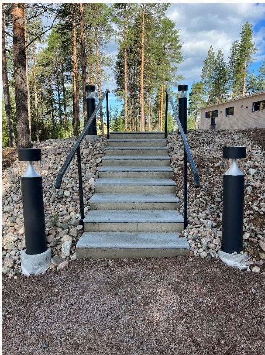
Kuva 10. Kappelille paikoitusalueelta johtavat portaat rakennettiin peruskunnostuksen yhteydessä helpottamaan kulkemista. Kappelille pääsee myös autolla, seinustalla on inva-paikkoja liikuntaesteisiä varten.
